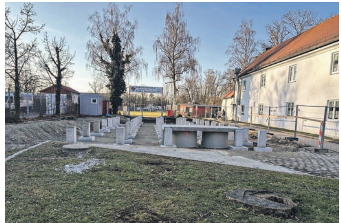
Die Fundamente für das Sportlerhaus sind gesetzt.
